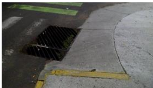
Ilustración 3: Rejas que obstruyen la circulación y uso de las rampas (Solano, 2018).
