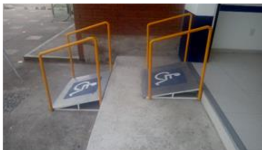
Ilustración 4: Rampas improvisadas y sin respeto por las pendientes óptimas (Solano, 2018).
