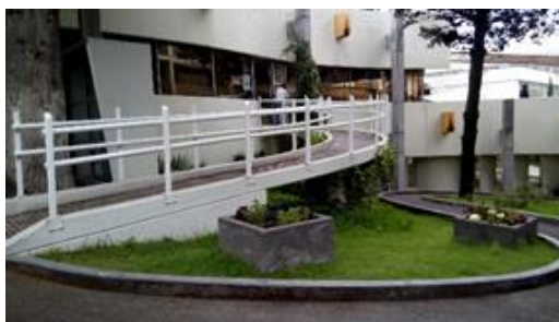
Ilustración 5: Rampa de acceso cuya forma curva dificulta la circulación con silla de ruedas (Solano, 2018).
