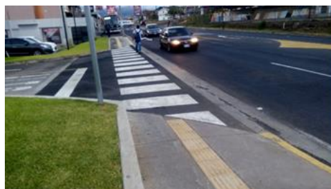
Ilustración 9: Guías tactopodales en banquetas que se interrumpen en los arroyos, cuando el código debiera ser continuo, previa advertencia de la diferencia de uso (Solano, 2018)
