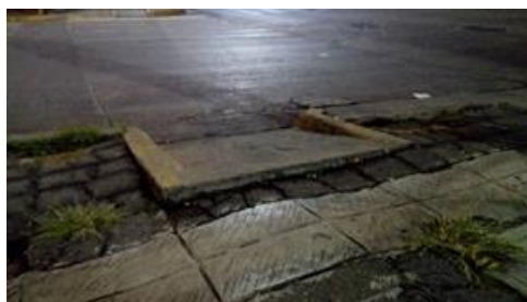
Ilustración 2: Rampas prefabricadas que no se ajustan a los niveles existentes, lo que imposibilita su uso (Solano, 2018).
