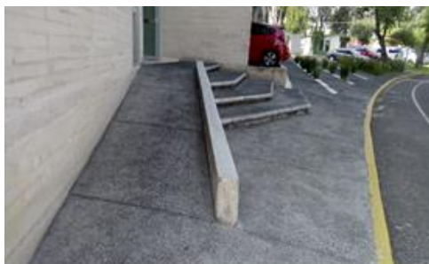
Ilustración 7: Anchos y pendientes poco confortables para usuarios de sillas de ruedas (Solano, 2018).
