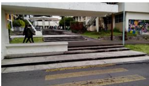
Ilustración 6: Discontinuidad de rampas, a la que se puede acceder librando primero una escalinata que le antecede (Solano, 2018).
