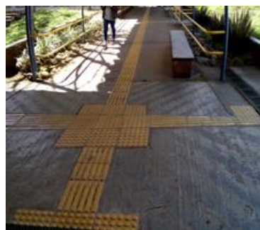
Ilustración 8: Falta de continuidad en el diseño de táctiles antideslizantes para invidentes (Solano, 2018)
