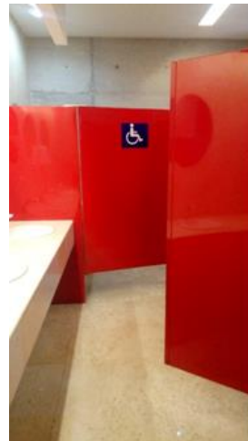
Ilustración 11: Sanitarios para personas con discapacidad colocados al fondo, lo que complica su acceso, sumado al inconveniente abatimiento exterior de las puertas (Solano, 2018).
